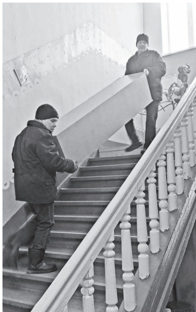
Помещение школы-интерната полностью освобождено, начались ремонтные работы.
